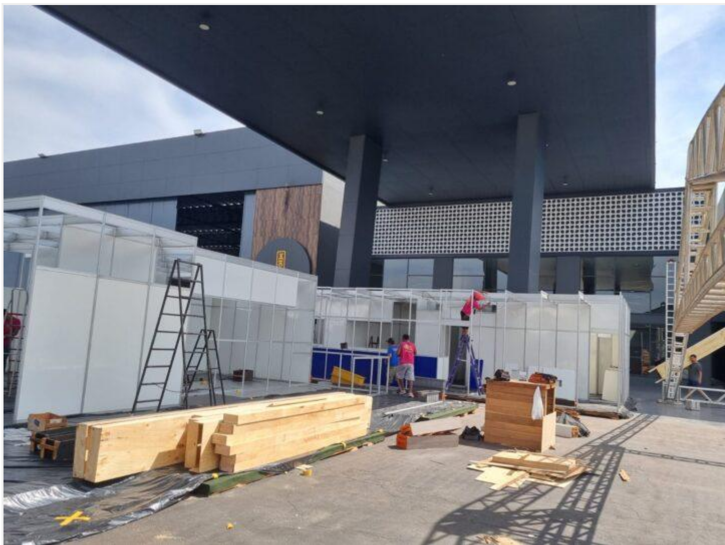
ESTRUTURA: estandes de mostras, os auditórios, espaços institucionais e áreas de serviços já estão sendo erguidos no espaço dos hangares e o pátio de manobras de aeronaves
