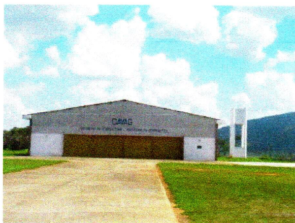
Instalações do CAVAG na Fazenda Ipanema. Iperó, São Paulo
