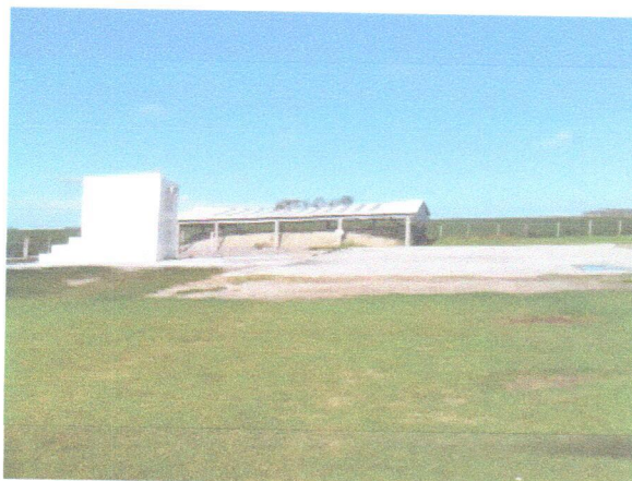
Pátio de descontaminação, com ozonizador e evaporador
